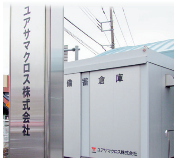
❖本社の入口横に配備した防災備蓄倉庫は2坪タイプ。BCPとしてバックアップ用の蓄電池も備えている
