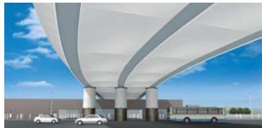
2009年「高潮橋桁化粧材」として膜構造製品化。
